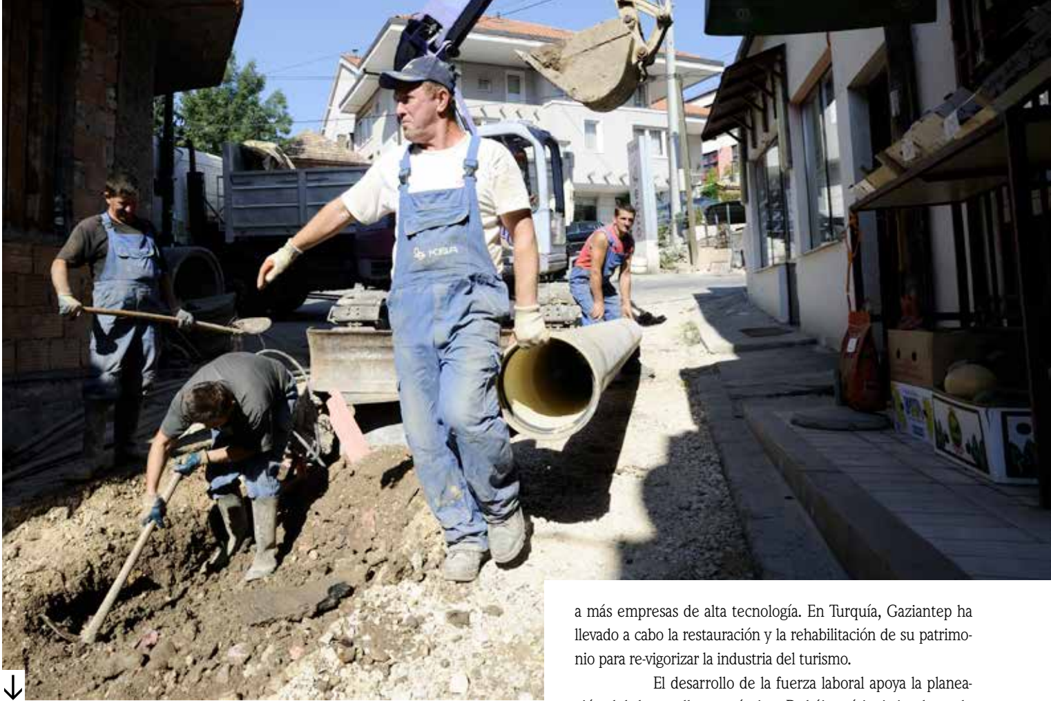
Reparación de las redes de aguas residuales en Sarajevo, Bosnia y Herzegovina.
